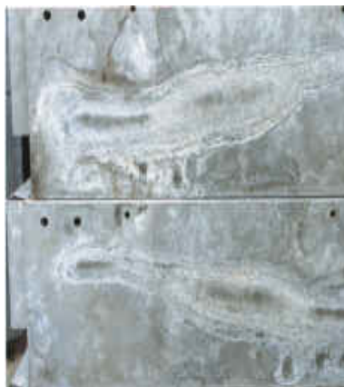
Fig.1: Aspecto de unos recipientes galvanizados para agua después de varios meses de almacenamiento a la intemperie. El apilamiento de unos sobre otros, con sus superficies planas en contacto, impidió la libre circulación del aire entre las mismas, con el resultado de formación de manchas blancas.
